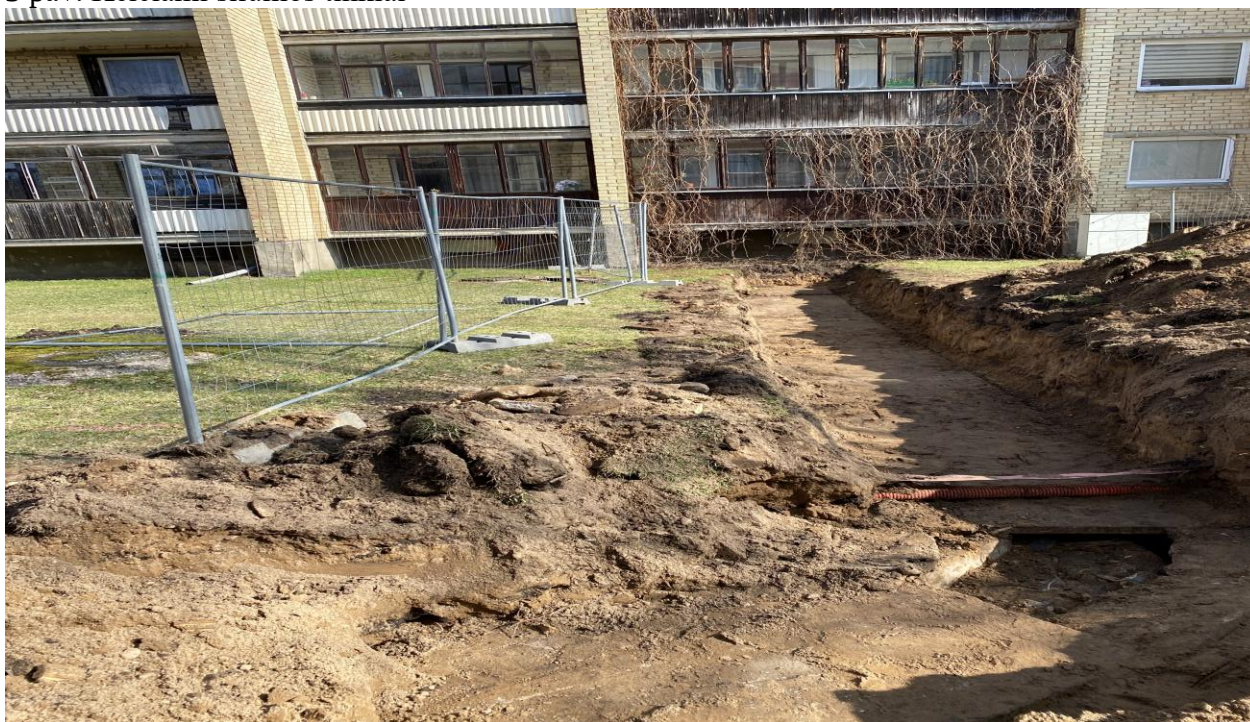
3 pav. Keičiami šilumos tinklai
